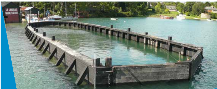
Chantier naval et cale sèche de La Landriais
