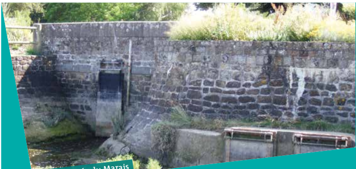
Porte à marée du Marais
