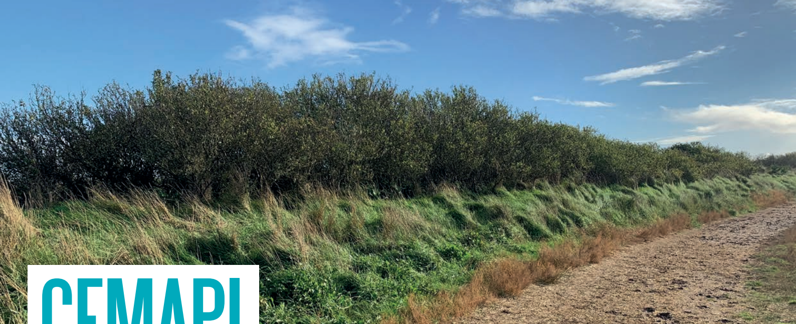
Digue de la Roche à Lancieux avant les travaux d'arasement
