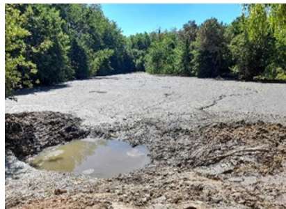
Plan d'eau du Moulin Riot en fin de vidange. Les sédiments qui doivent normalement circuler dans les rivières sont bloqués en amont de la digue.
