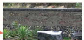
MUR FAÇON PISÉ
